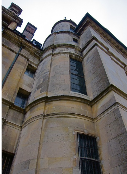
Fig. 7 Château d'Écouen, Turret on the South Façade.
