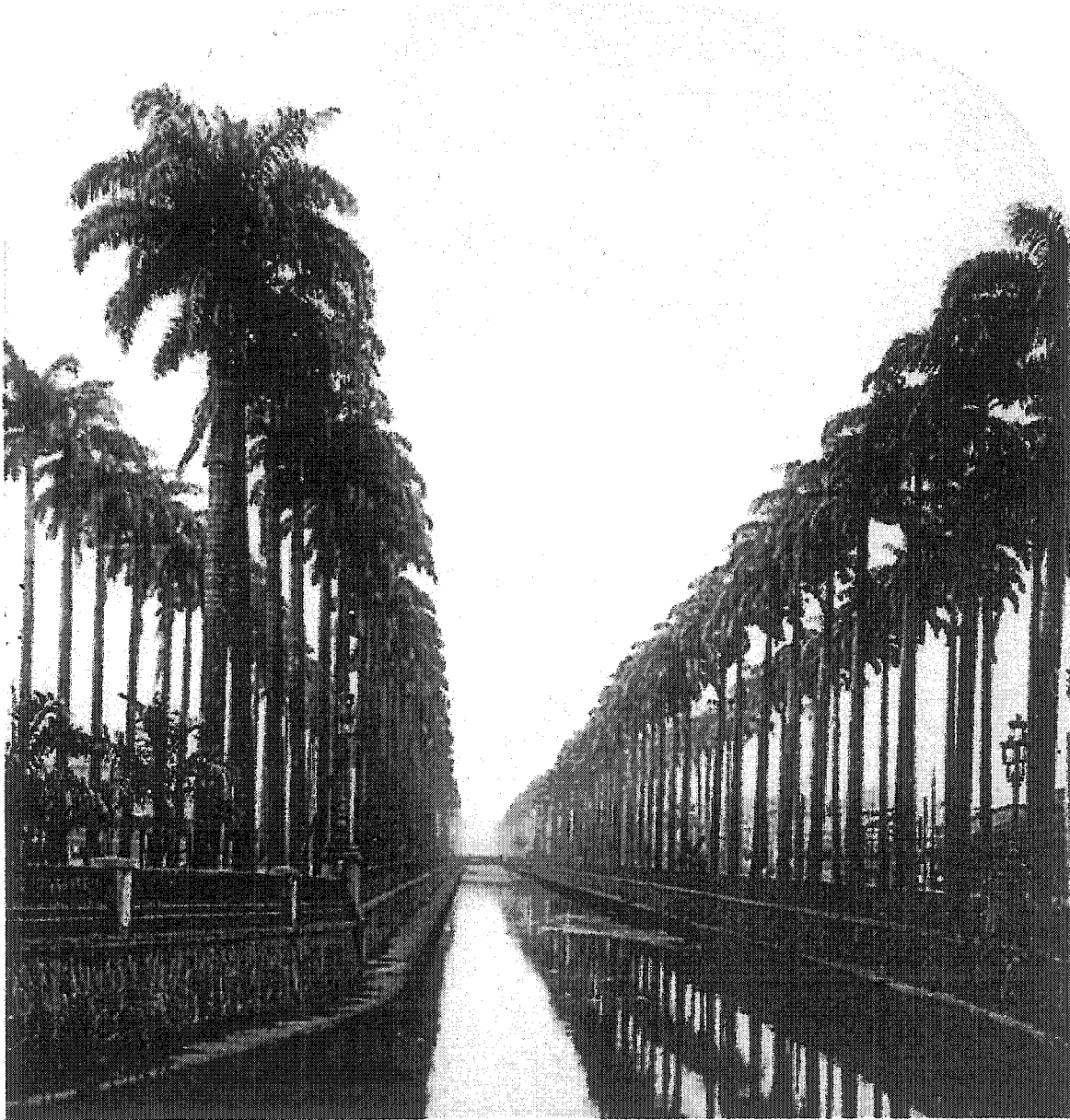
Fig. 39. Stereoscope view of the Mangue Canal, Rio de Janeiro
